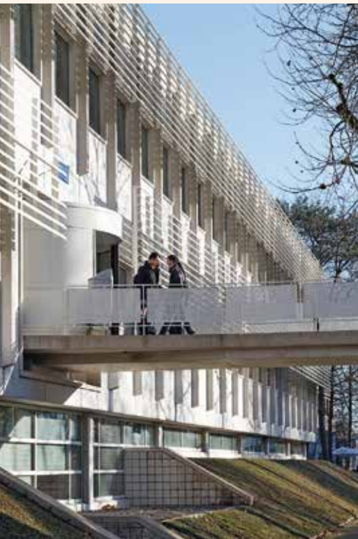
1. Buitenkant van de UB Tilburg
